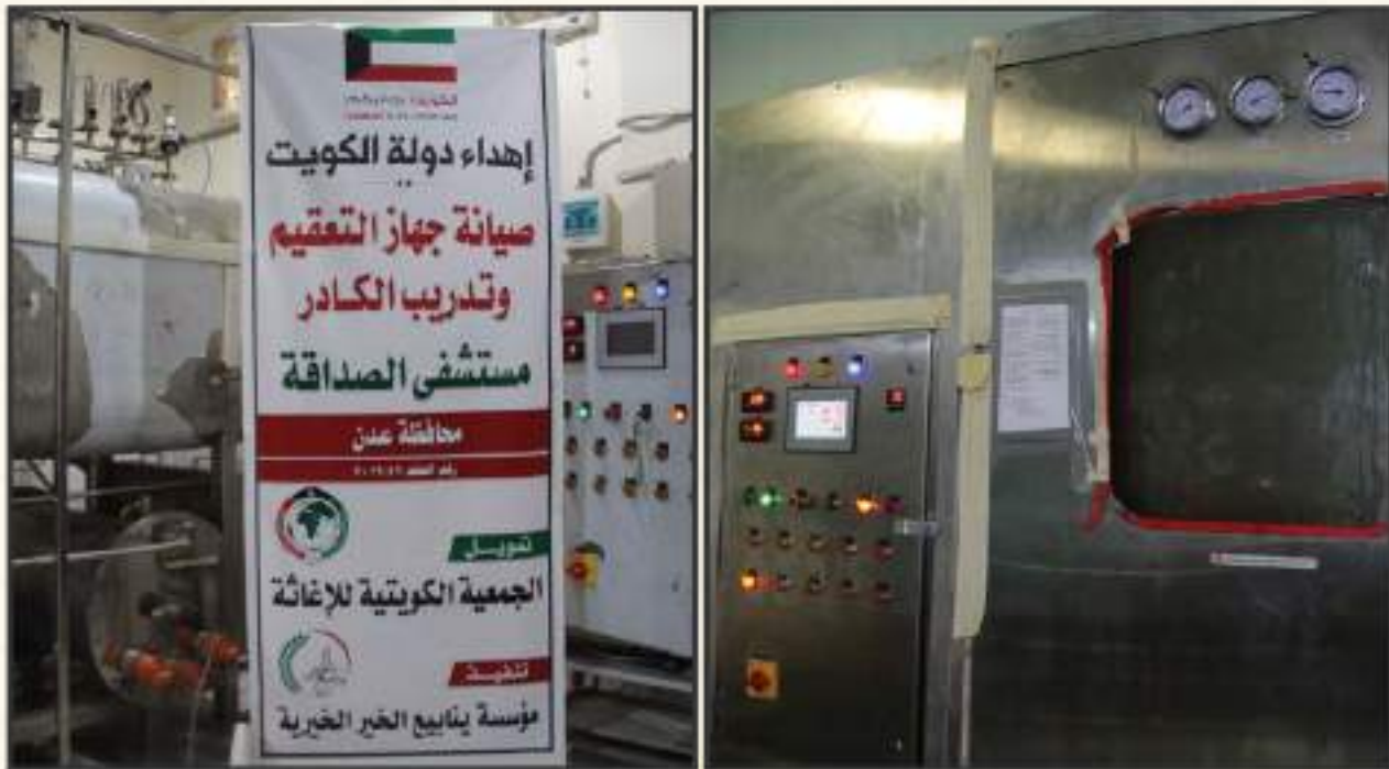
تركيب وتشغيل جهاز التعقيم مستشفى الصداقة - عدن
